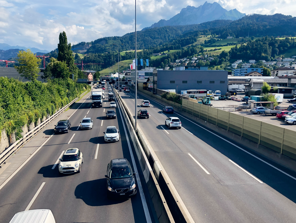
Der heutige Raum der Autobahn A2 im Gebiet Wyssmatt/Nidfeld ohne Überdeckungen.
