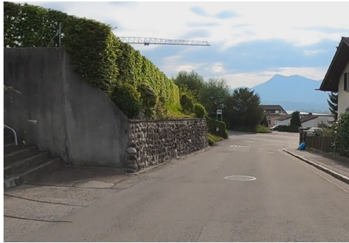
Abbildung 2: Bereich Kaphaltestelle Dattenberg, Richtung Ost
