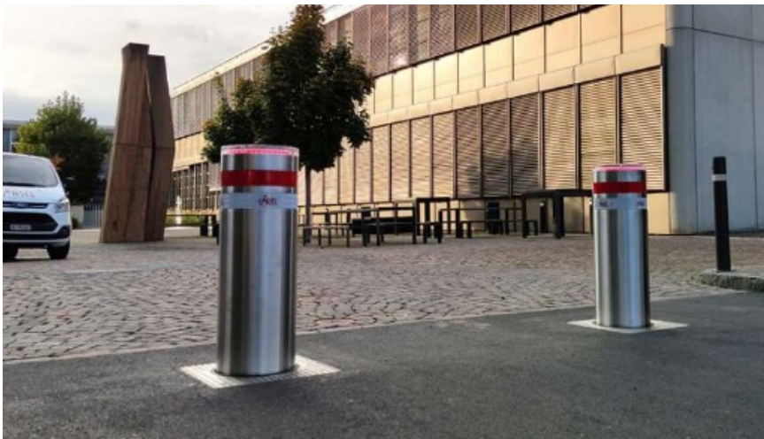
Abb. 27: Beispiel elektrisch versenkbarer Poller
