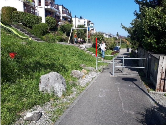
Abb. 23: Variante 3: Fahrbahnrad (Doppelmeter, rot) Teil gemischt Breite 3.5 m (Blick Richtung Luzern)
