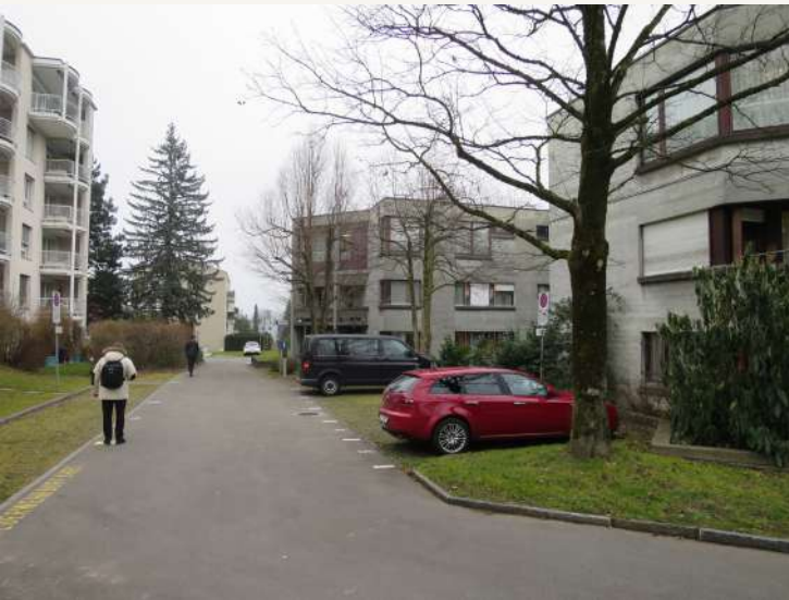
Resträume Unklare Adressierung
