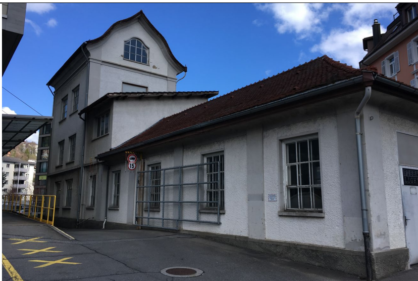
Abbildung 100.: hydraulische Versuchsanlage, Foto Planteam S AG, März 2019
