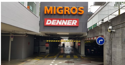
Abbildung 55.: unterirdische Ost-West Achse Hofmattweg, Foto Planteam S AG, 2019
